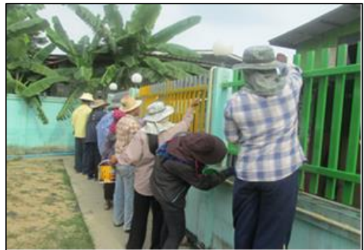
ภาพที่ 7-4 เปลี่ยนสีทาสีอาคารเป็นสีปลอดภัยตะกั่ว
