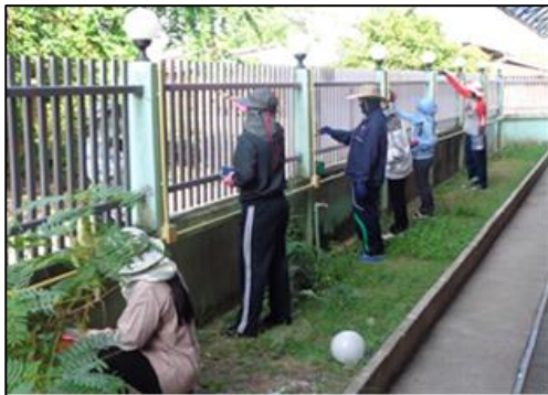
ภาพที่ 7-4 เปลี่ยนสีทาสีอาคารเป็นสีปลอดภัยตะกั่ว
